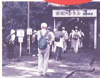
▲赤坂トンネル 現在は自転車道として使われている
