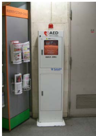
設置場所の一例 (改札付近)
