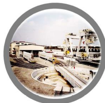
PC 軌道桁製作場 モールド台車回転装置
