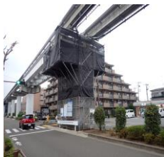
▲ R C 支柱補修工事
