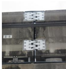
▲ 軌道桁の伸縮装置
