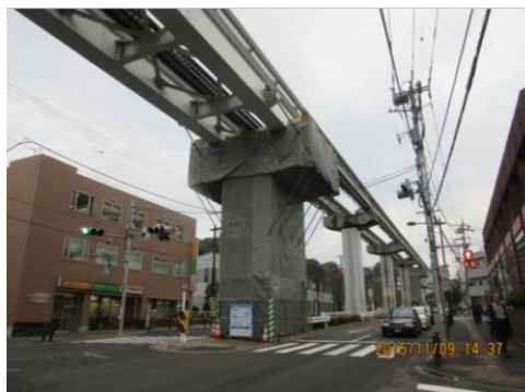
R C 支柱補修用足場設置状況
