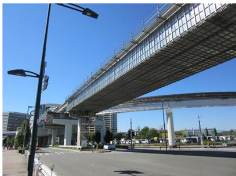
鋼軌道桁塗装用足場設置状況
