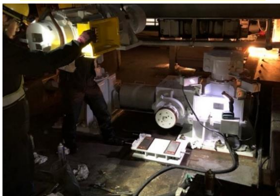
駆動モータ交換作業状況
