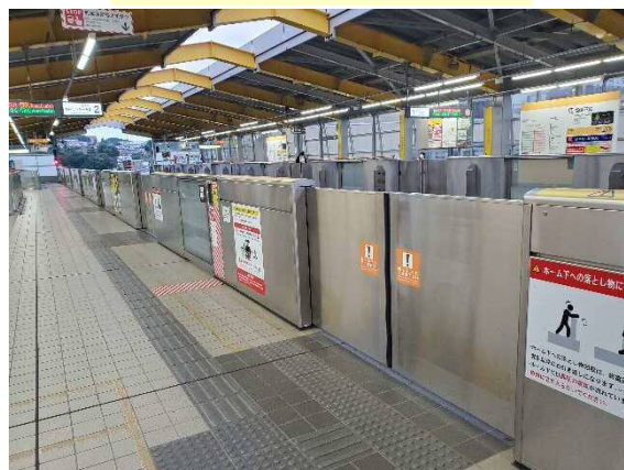
駅におけるホームドア設置状況
