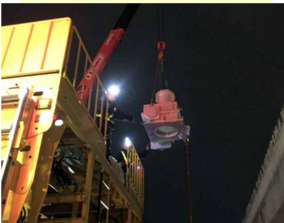
分岐器駆動装置更新（多摩センター分岐）
