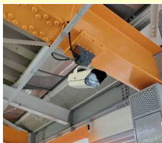
監視カメラ (ホーム)
