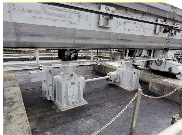
減速機の更新（多摩センター分岐・完了）
