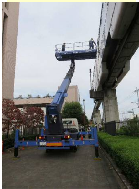
高所作業車による応援係員送り込み
