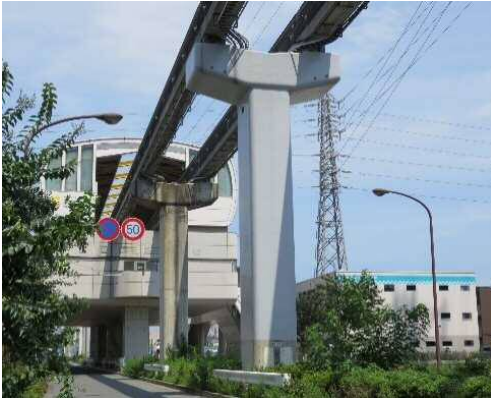
RC 支柱補修
