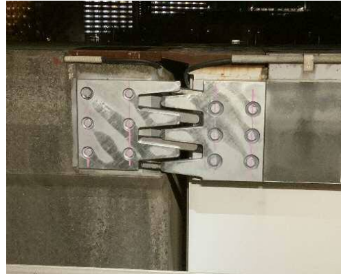
軌道桁伸縮装置更新
