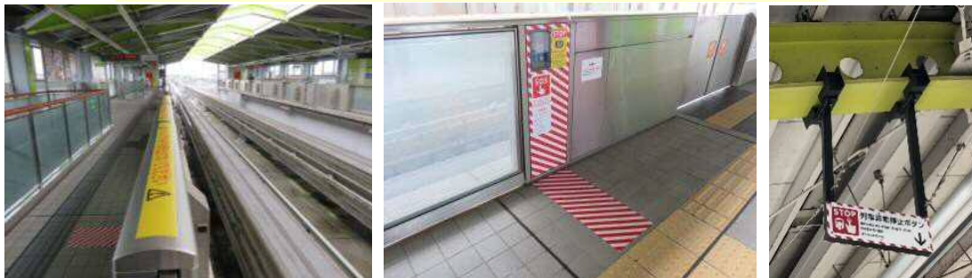
ホームドアラッピングと列車非常停止押しボタン等の明確化
