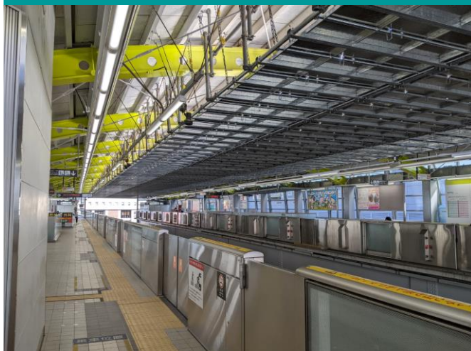
駅舎塗装修繕（立川南駅）
