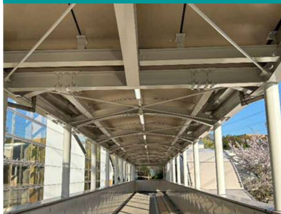
駅舎通路部塗装塗替え（中央大学・明星大学駅）
