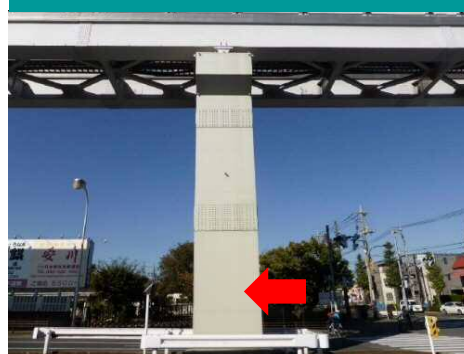
内部にコンクリートを詰めた鋼製支柱
