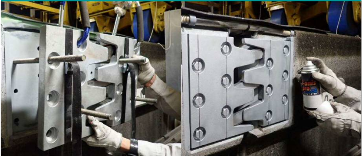
軌道桁伸縮装置更新
