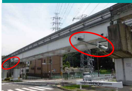
落橋防止装置を設置した軌道桁
