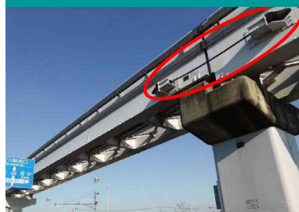
連結した軌道桁
