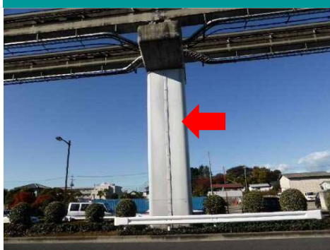
鋼板を巻いたコンクリート製の支柱
