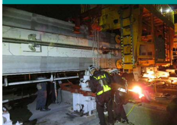
減速機の更新（高松分岐器）
