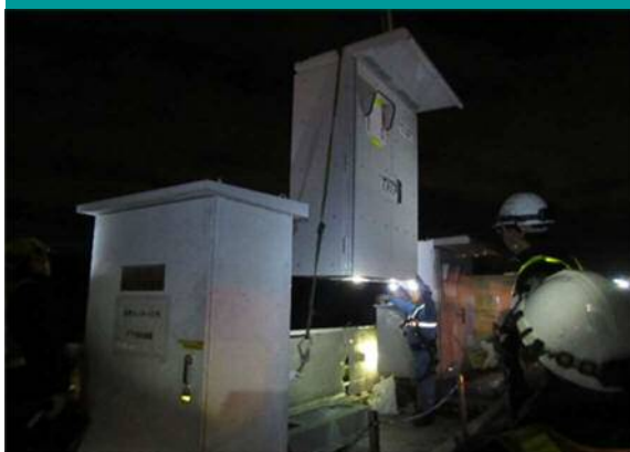
制御装置の交換（多摩センター分岐器）
