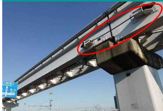
コンクリート製支柱には、鋼板等を巻いて水平方向の耐力を向上させる等の補強を行っております。また、同様の目的で、鋼製支柱には、内部にコンクリートを詰めて強度を高めております。
