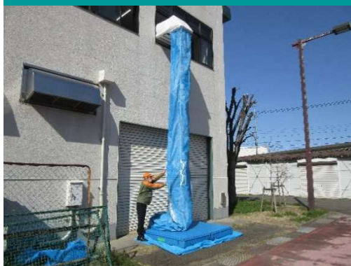
運営基地内に設置した訓練設備
