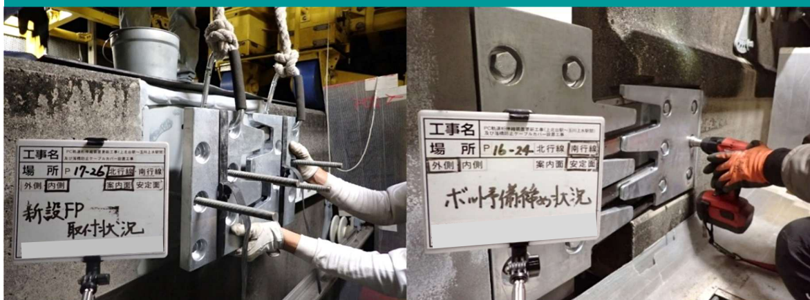
軌道桁伸縮装置更新
