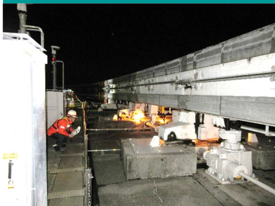
設備係員による軌道施設点検
