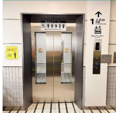
エレベーター更新（泉体育館駅）
