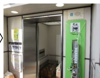
ステップ3 仕上げ工事
