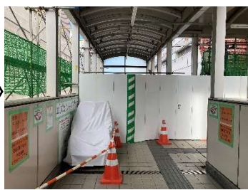
ステップ1 仮設・解体工事
