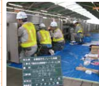
●可動式安全柵（ホームドア）オーバーホール
