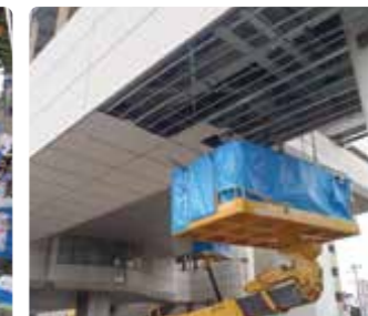
●通路部軒天井修繕
