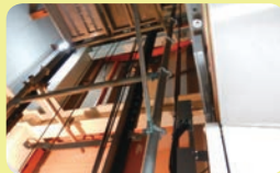
工事中のエレベーター内部
